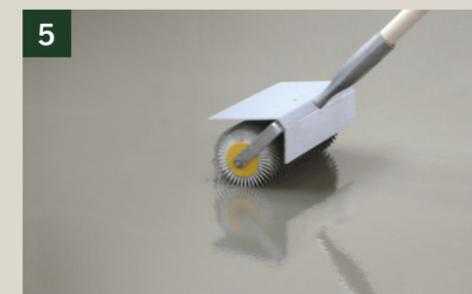
5 In dünnenschichtigen Anwendungen bis 10 mm kann die Entlüftung der Masse mit einer Stachelwalze unterstützt werden.
