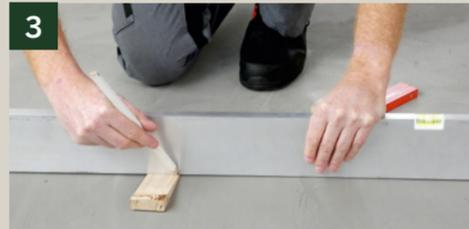
3 Toleranzen werden mit Richtsheit und einem Keil ermittelt. Dazu den Keil bis zum Anschlag unterschieben.
