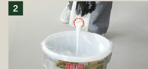
Gebinde aufschütteln, anschließend öffnen und zur weiteren Verarbeitung in den ZUBEHÖREIMER gießen.
