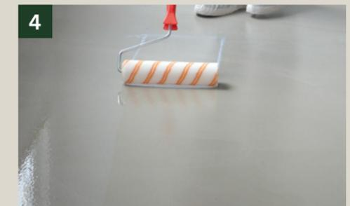
**4** Die BODENVERSIEGELUNG mit Rolle Bodenversiegelung aus dem Eimer entnehmen und auf dem Untergrund gleichmäßig vollflächig aufrollen.
