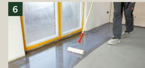
Anschließend den Flächenauftrag mit der Rolle vornehmen.
