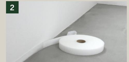
2 Der RANDDÄMMSTREIFEN wird durch abziehen der rückseitigen Folie an die Wandfläche geklebt.
