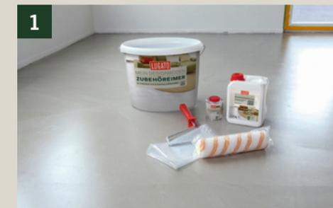
**1** Für die Verarbeitung von BODENVERSIEGELUNG wird der ZUBEHÖREIMER mit einem Folienbeutel ausgekleidet.
