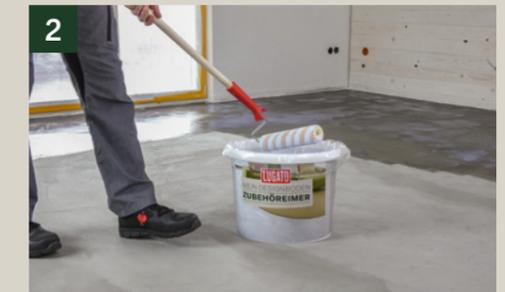
2 Grundierung mit Rolle aus dem Eimer entnehmen und ...
