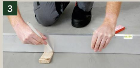
3 Toleranzen werden mit Richtsicht und einem Keil ermittelt. Dazu den Keil bis zum Anschlag unterschieben.
