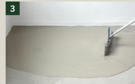
3 Die ausgebrachte Masse mit einem Raketl gleichmäßig verteilen.
