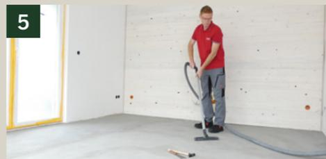
5 Sind alle Parameter geprüft, wird die Fläche porentief mit geeignetem Baustaubsauger gesaugt.
