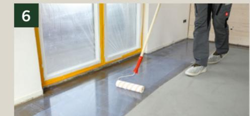
Anschließend den Flächenauftrag mit der Rolle vornehmen.
