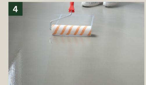
Die BODENVERSIEGELUNG mit Rolle Bodenversiegelung aus dem Eimer entnehmen und auf dem Untergrund gleichmäßig vollflächig aufrollen.
