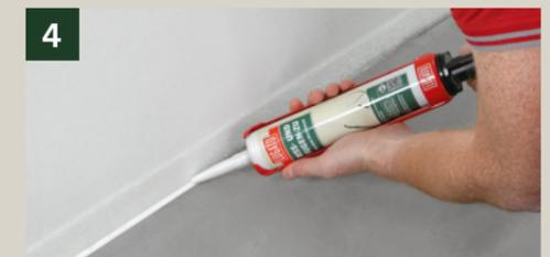
4 Um das Unterlaufen des RANDDÄMMSTREIFENS mit BETONMASSE zu verhindern, kann zusätzlich mit RISS-UND-FUGEN-ZU der untere Rand versiegelt werden.
