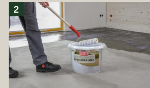
2 Grundierung mit Rolle aus dem Eimer entnehmen und ...
