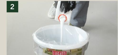
Gebinde aufschüteln, anschließend öffnen und zur weiteren Verarbeitung in den ZUBEHÖREIMER gießen.
