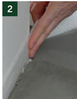
... und den RANDDÄMMSTREIFEN ohne Zugspannung mit ausreichendem Druck an die Wandfläche ankleben. An den Innen- und Außenecken kann der RANDDÄMMSTREIFEN geknickt werden.
