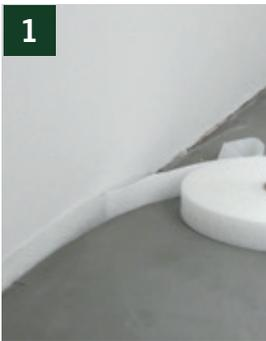
RANDDÄMMSTREIFEN abrollen und auf die benötigte Länge zuschneiden. Rückseitige Schutzfolie bereichsweise abziehen ...
